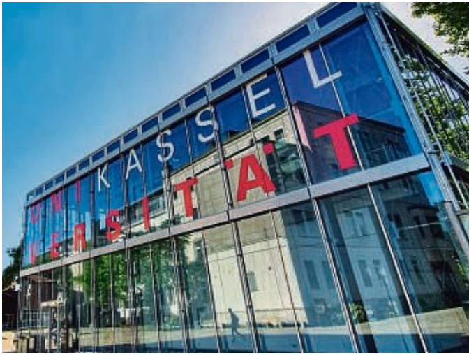
Auch am Holländischen Platz wird investiert: Etwa 7,5 Millionen Euro kostet es, das Institutsgebäude Ingenieurwissenschaften III energieeffizienter zu machen. Unser Bild zeigt den Glaskasten an der Kurt-Wolters-Straße.
